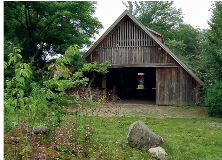
Außenansicht der Scheune Quelle: PBS-Team
