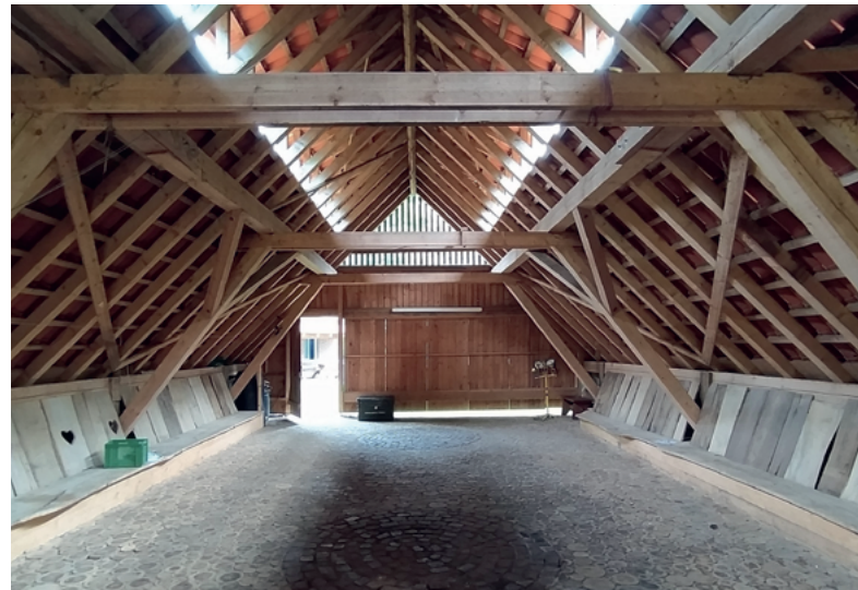
Innenansicht der Scheune
